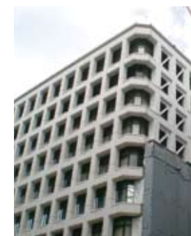
本社ビル 2008年に耐震補強工事実施
