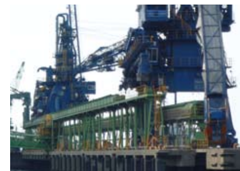
震災直後の鹿島工場埠頭 耐震補強により震災被害はほとんどありませんでした
