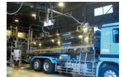
ローリー専用洗車場
