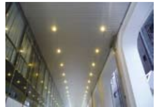
本社ビルLED照明
