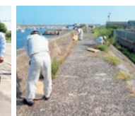
堤防清掃 （敷島スターチ（株））
