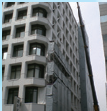
本社ビル耐震補強工事 (平成20年実施)
