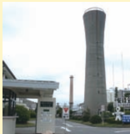
三重県鈴鹿市長太(なご)にある敷島スターチ本社・工場
