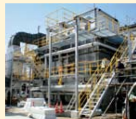
建設中の木質チップボイラー
