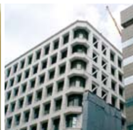
災害対策ビル補強工事
