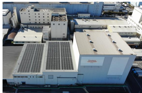
【船橋工場立体倉庫屋上に設置した太陽光発電設備】
